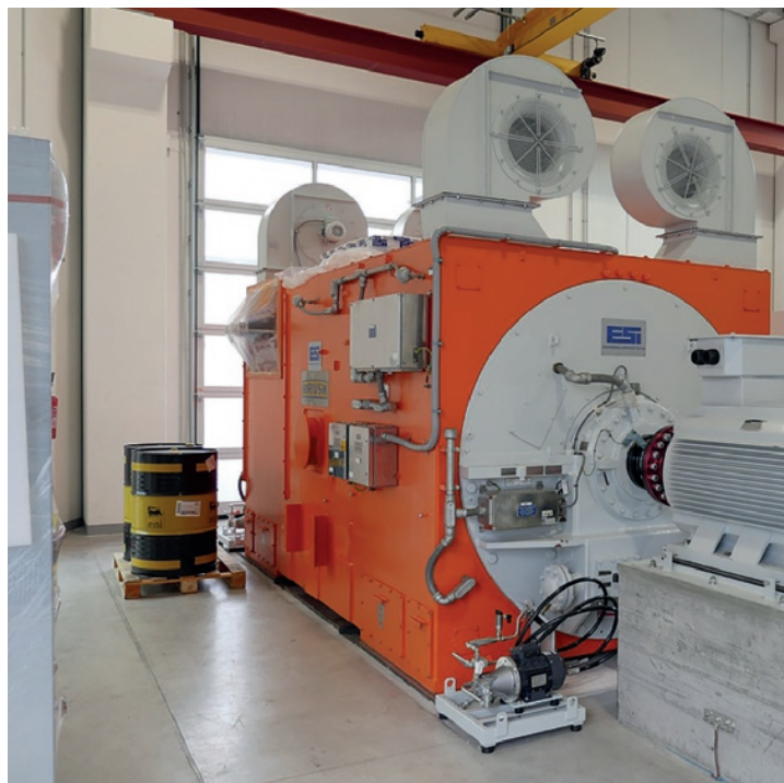
Un particolare della Sala Macchine dedicata ai test di cortocircuito e sovraccarico
