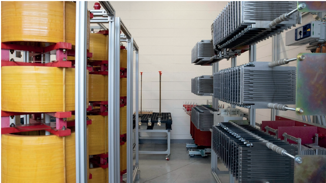
Un altro dettaglio dell’imponente sistema che fornisce la potenza necessaria per le prove di laboratorio
