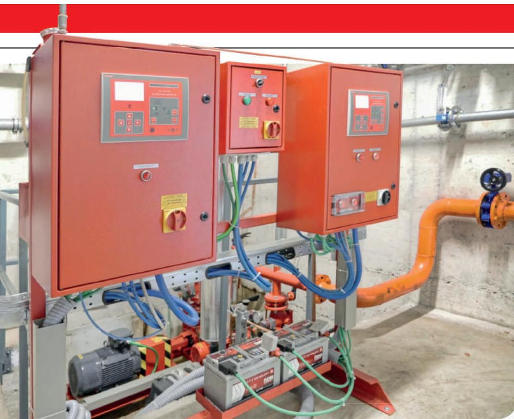
il controllo, il monitoraggio e la protezione dell'elettropompa secondo la norma UNI EN12845. L'utilizzo del pannello frontale è molto intuitivo e semplice grazie al display grafico da 128x80 pixel, ai LED e ai pulsanti dedicati. La linea di alimentazione e la pompa elettrica sono completamente monitorate dal controllore.
