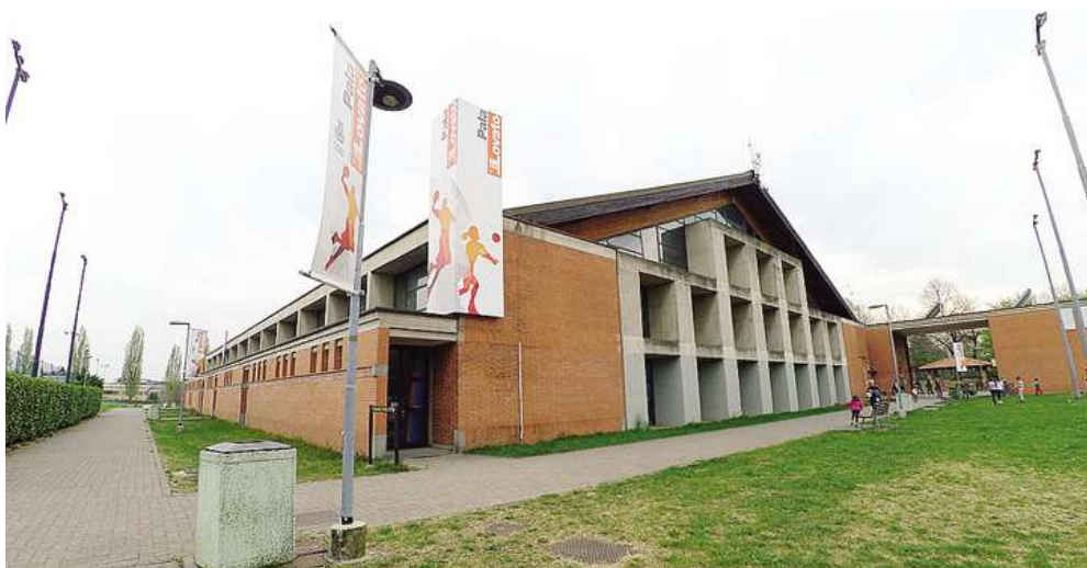
Il Palalovato di Gorle: in estate previsti lavori per 120 mila euro FOTO GIAVAZZI
